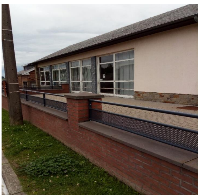
La nouvelle école gardienne de 1962 (bâtiment sans la salle de psychomotricité bâtie beaucoup plus tard.)
